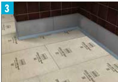
(Optionnel) Installez des languettes d'expansion le long de tout périmètre ou des joints d'expansion sectionnels dans le sous-plancher afin de préserver leur fonction.
