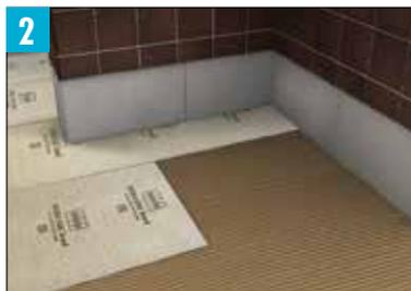
Étape recommandée : Posez des panneaux HYDRO BAN<sup>®</sup> pour l'isolation sur le sous-plancher selon les instructions de pose DS-040.0.
