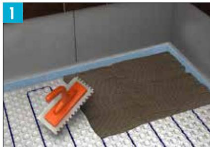
Recouvrez le tapis et le fil STRATA\_HEAT™ avec une couche de mortier modifiée d'un minimum de 6 mm (1/4 po). Assurez-vous de ne pas endommager ou déplacer le fil STRATA\_HEAT. Ne posez pas des carreaux d'une longueur ou largeur inférieure à 89 mm (3 1/2 po).
