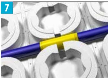
Le fil STRATA\_HEAT<sup>™</sup> est fabriqué de manière à ce qu'il y ait une union à l'endroit où le câble chauffant rencontre le fil d'alimentation. **Cette connexion est marquée avec du ruban adhésif et DOIT être installée dans le tapis STRATA\_HEAT et recouverte d'adhésif et non exposée.** Assurez-vous que cette connexion est installée directement dans le tapis STRATA\_HEAT et qu'elle n'est pas pliée autour d'une cheville.
