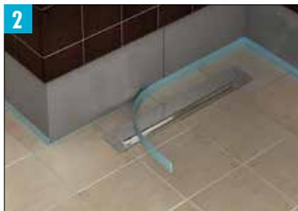
Les languettes de périmètre doivent être coupées à ras avec les carreaux à l'aide d'un couteau tout usage.
