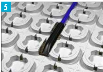
À l'extrémité du fil STRATA\_HEAT<sup>MC</sup>, vous trouverez une union de terminaison. Pour assurer un bon ajustement, les chevilles de membrane peuvent être coupées de manière à ce qu'elles soient au même niveau, avant d'être intégrées dans le mortier-colle.
