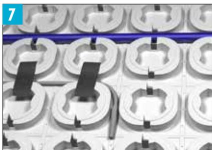
Mesurez la résistance de la sonde de plancher en enregistrez-la sur la carte de contrôle à la page 32. Si sa valeur de résistance est hors de la plage prescrite, communiquez avec notre ligne d'aide technique.
