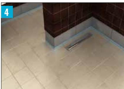
Les planchers carrelés peuvent habituellement être jointoyés dans les 24 heures ou le jour suivant. N'activez PAS le fil STRATA\_HEAT avant que l'adhésif et le coulis de revêtement de carreaux n'aient complètement séché. N'utilisez PAS le fil STRATA\_HEAT pour accélérer le processus de séchage de l'adhésif.
