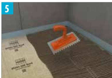
Appliquez une couche de mortier sur le substrat à l'aide d'une truelle à encoches carrées de 6 mm x 6 mm (¼ po x ¼ po).
