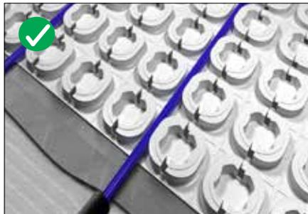
Le fil STRATA\_HEAT ne peut pas être posé sur des joints d'expansion dans le plancher. Lorsqu'un plancher chauffé est divisé par des joints d'expansion, des fils individuels doivent être utilisés pour chauffer chaque zone. Le fil d'alimentation peut croiser le joint d'expansion dans un conduit certifié UL/cUL d'une longueur de 30 cm (12 po) au besoin.
