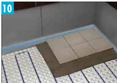
Posez les carreaux sur le tapis et le fil STRATA\_HEAT. Le fil STRATA\_HEAT, y compris l'union et l'union de terminaison, doit être complètement encastré par l'adhésif des carreaux et non exposé. Utilisez le coulis PERMACOLOR<sup>™</sup> ou SPECTRALOCK<sup>™</sup> pour le jointoiment.
