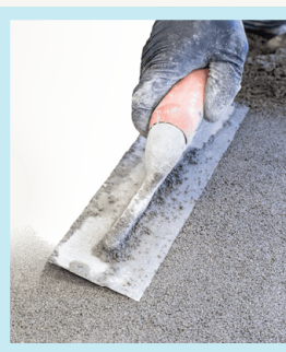
Preparación de superficie
